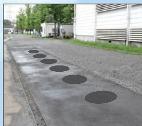
マンホール (W22側7台)
