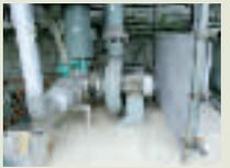
排気用プロア(2台)および設置したブロック防音壁
