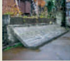
擁壁上から倒壊したブロック塀(2004年新潟県中越地震)
