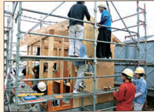
▲施工作業風景
