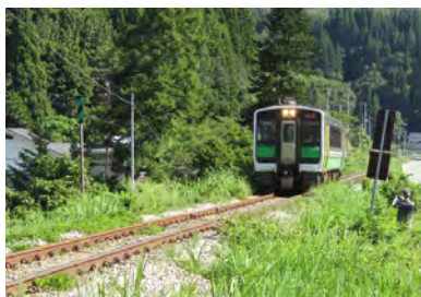
現地調査：2022 年に復旧した「只見線」
