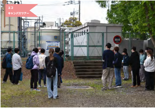
防災井戸水浄化装置の見学
