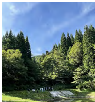
現地調査：農業用ため池
