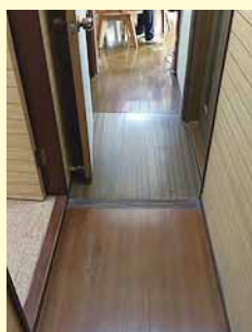
廊下の段差を解消。歩行時でも車椅子を利用するようになって移動しやすい。
