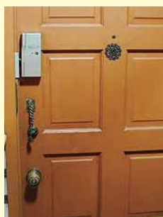
ヘルパーの出入りのために玄関のオートロック錠を設置。玄関まで行かなくても施錠可能。
