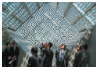
▲ 太陽光発電システム(ソーラーチューブ内)
