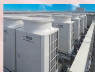
▲EHP空調室外機
