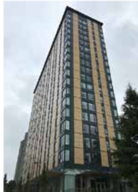
18階建て木造ビル
