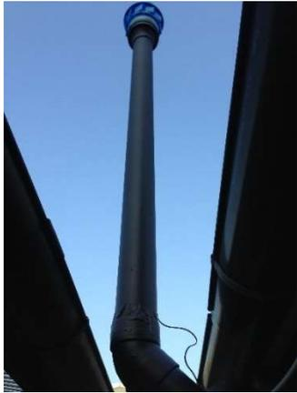
換気用の煙突は、つやのない黒色塗装をして、長く伸ばしています。これにより、煙突内が日射で温められることで温度差による自然換気が促進されます。
