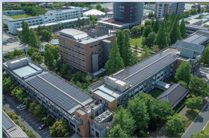
▲本館屋上 400kW
