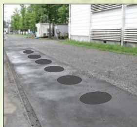
災害用トイレ鉄蓋(W22側7台)
