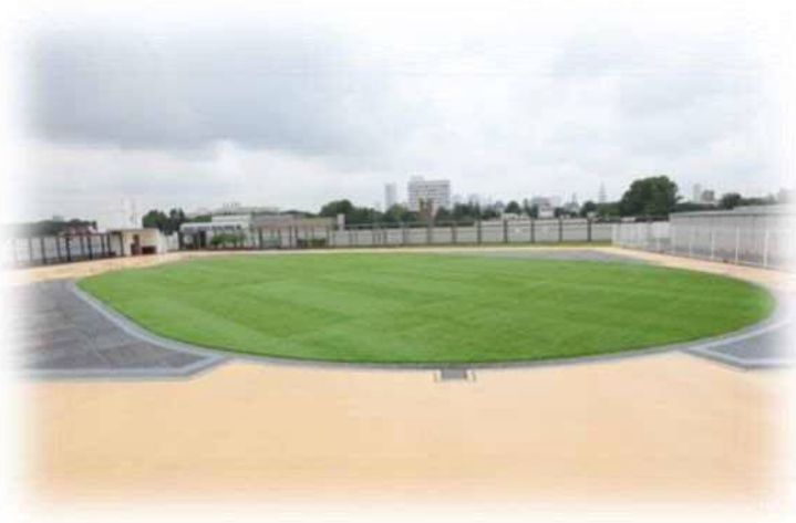
校舎屋上の人工芝設置
