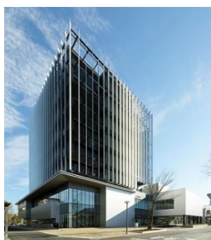
5号館（多目的講義棟）
