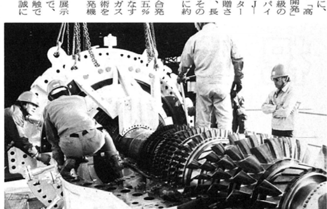
工業技術博物館に搬入されるレヒートガスタービン
