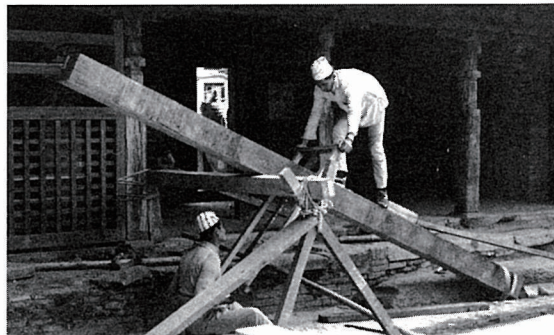
第1期工事中のネパール職人
