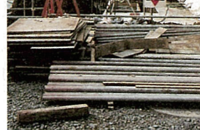
現在の工事状況
