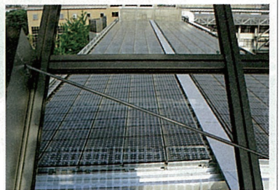
同上からみた屋根の部分
