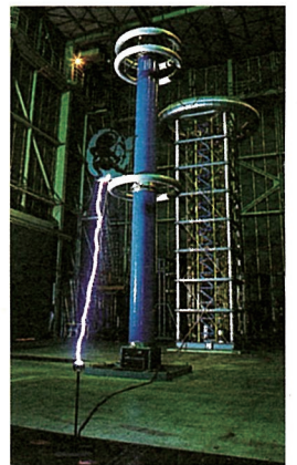
インパルス電圧発生装置
