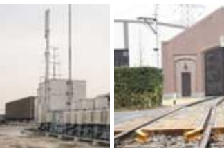
ドコモのアンテナ局 新しくなった枕木
