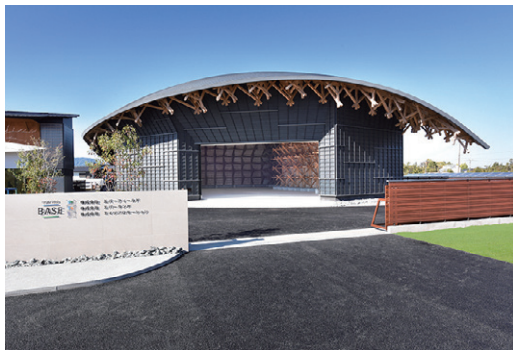
木材加工場の外観 Photo: くまもとアートポリス
