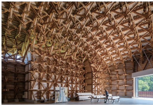
製材が支え合う構造 Photo: YASHIRO PHOTO OFFICE
