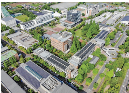
本館屋上の発電装置も更新
