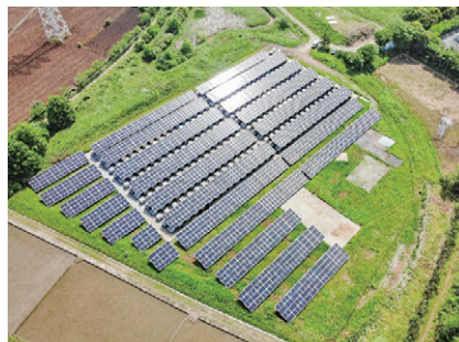
キャンパス奥にある拡張地に発電装置を新設
