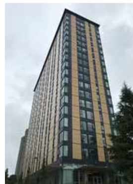
18階建て木造ビル
